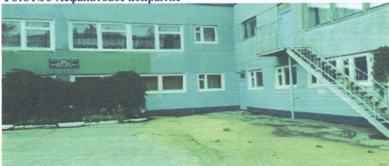
Фото № 3 Асфальтовое покрытие
