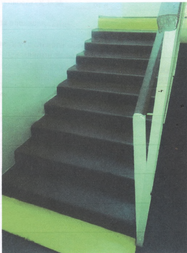
Фото № 9 Лестница на второй этаж
